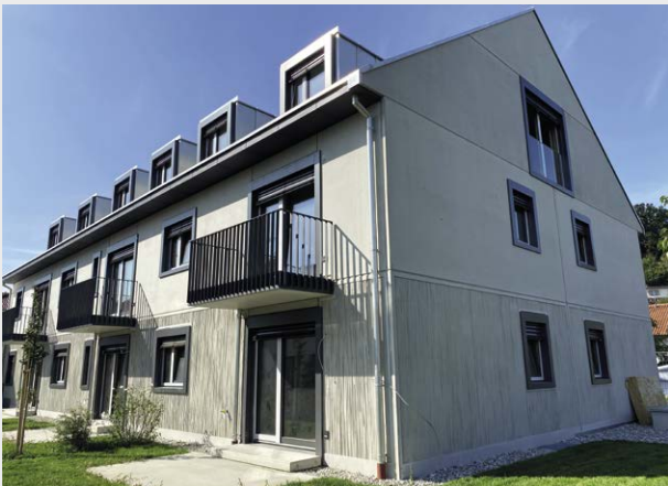
Abb. 16.1: Mehrfamilienhaus mit einer Architektur-Fertigteilfassade aus Beton
