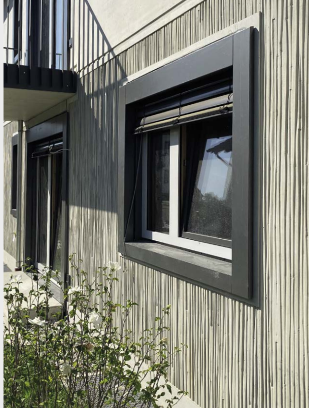
Abb. 16.2: Detailansicht der Fassade mit Rillenstruktur
